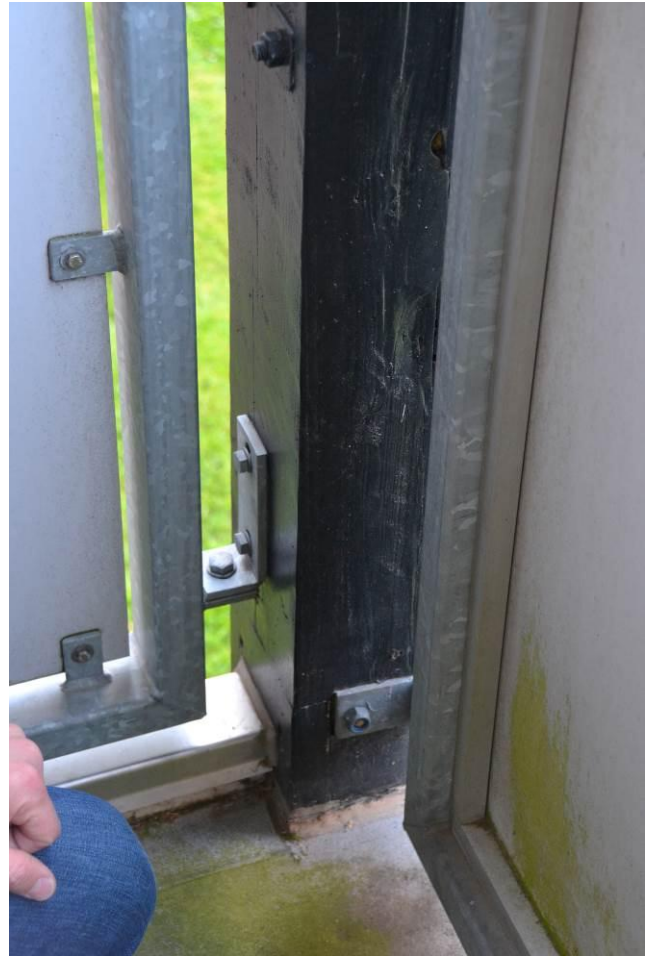
Der opstår rådskeer omkring beslag og inddækninger ved træstolperne.
