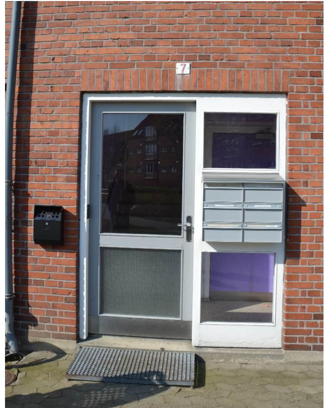
Indgangsdør på det nordlige afsnits nordfacade.
