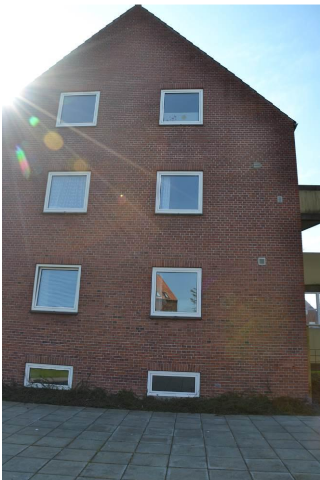
Gavl på det nordlige afsnit. På billedet ses, at der er indsat flere luftriste til ventilation af det bagvedliggende rum
