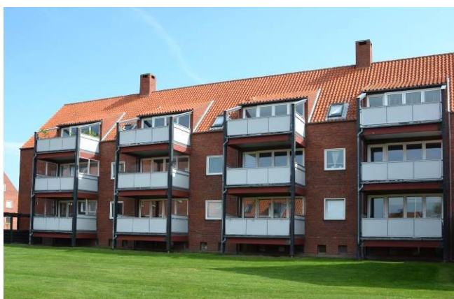
Altanløsning på det sydlige afsnit. Det er en søjlekonstruktion af træ, hvilket giver store rådproblemer i dag.
