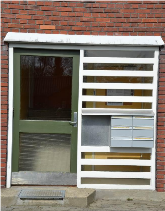
Indgangsdør på det sydlige afsnits nordfacade.
