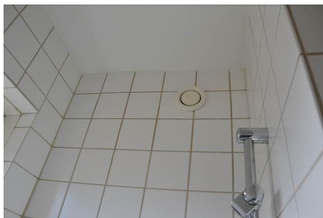
Der er aftræk fra både bad og køkken.
