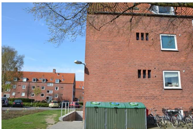
Udendørsbelysning på bygningshjørnerne.
