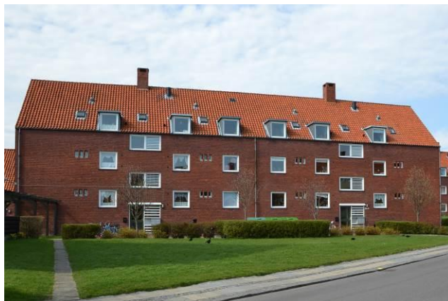
Nordfacade på det sydlige afsnit.
