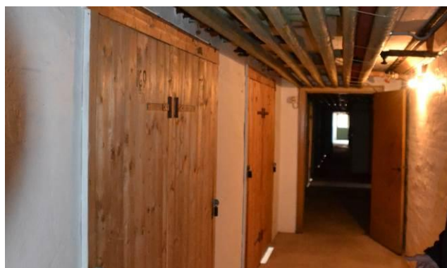
Pæne og tørre kælderrum.
