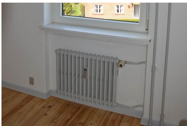
I gavlen sidder radiatoren i en niche i muren. Ved fraflytning flyttes radiatoren ud og nichen isoleres.
