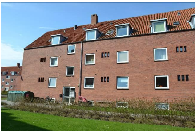
Nordfacade på det nordlige afsnit.
