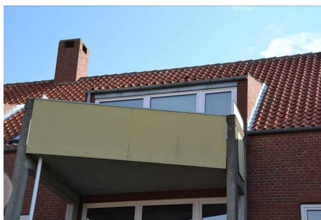
Taskekviste på sydsiden af bygningerne. Bør efterisoleres.
