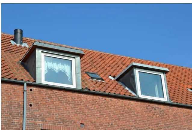
Fladtagskviste på nordsiden af bygningerne. Kvisten til venstre er efterisoleret i flunker og tag.
